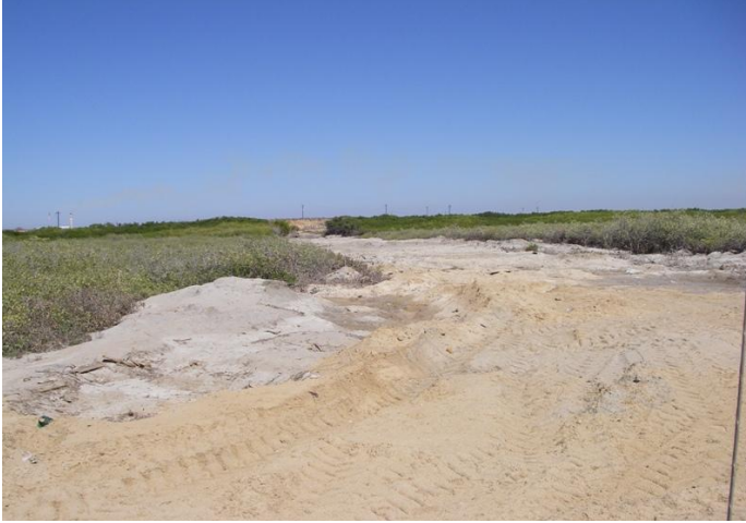
Figura 2. Construcción de caminos a través del hábitat de manglar cerca de la La Paz (foto: Jon Hak)
