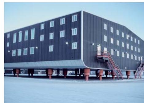
Операционный центр Бритиш Петролеум, построенный на сваях, чтобы избежать повреждений вследствие таяния вечной мерзлоты, залив Прюдо, Аляска
