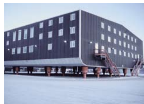
BPs operasjonssenter, Prudhoe Bay, Alaska, bygd på påler for å forhindre skade fra tinende permafrost.
