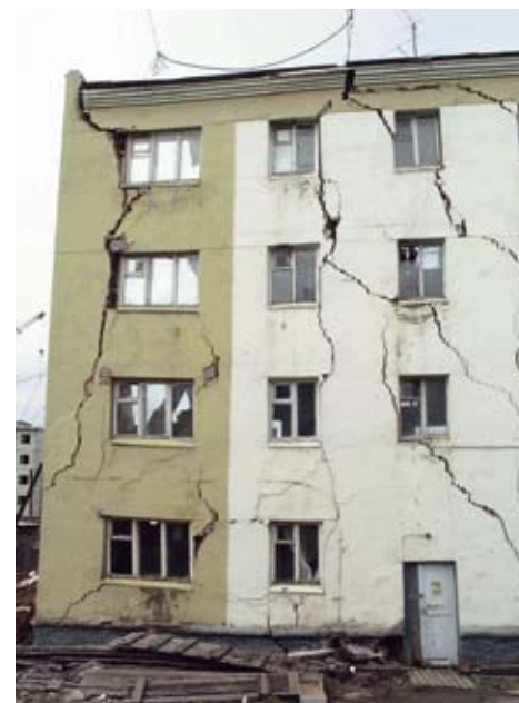
Bygning som er skadet pga. tining av permafrosten i Tsjaerskij (ved Kolyma-elvens nedre løp), Russland.
